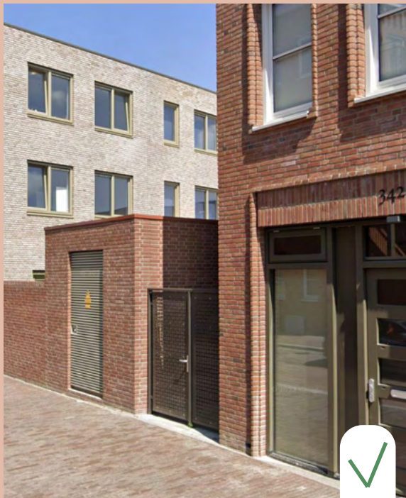
Trafo-ruimte onderdeel van de architectuur.
