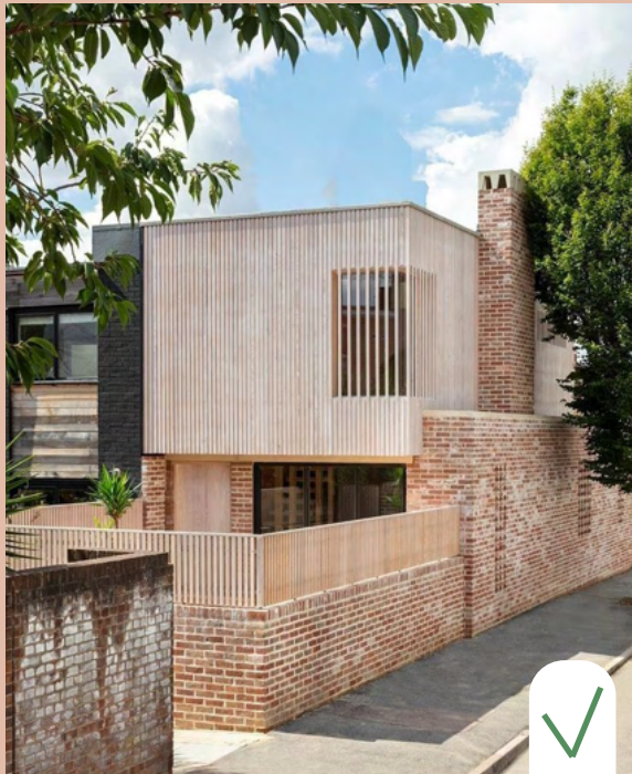
Metselwerk en hout, natuurlijke kleurstelling.
